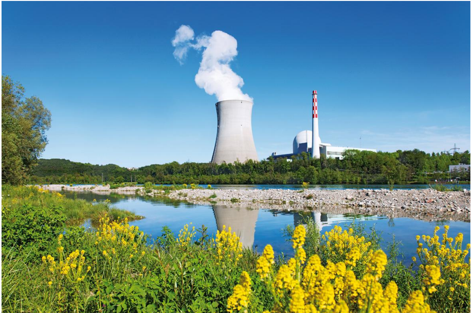
La centrale nucléaire de Leibstadt: la plus jeune et la plus puissante des cinq centrales nucléaires suisses. Photo: KKL
